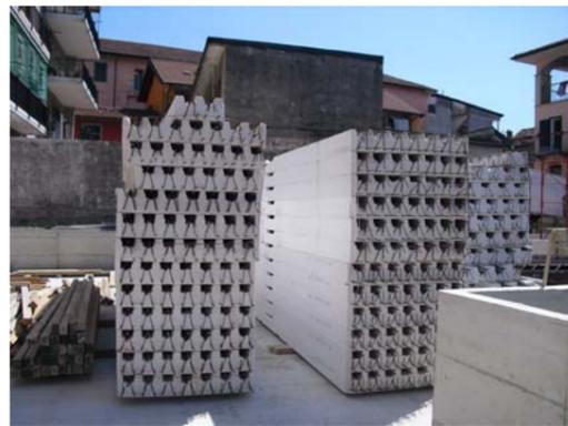
esposte ed i sistemi a secco di completamento, la tipologia dei solai è di tipo autoportante in polistirolo tipo Speedy della Polielit.
